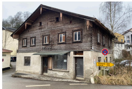
Abb. 80: Negativ ortsbildprägendes Gebäude
