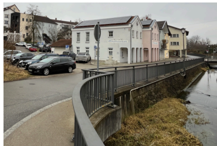
Abb. 79: Stark ausgebautes Gewässerbett sowie fehlende Zugänglichkeit zum Wanklbach
