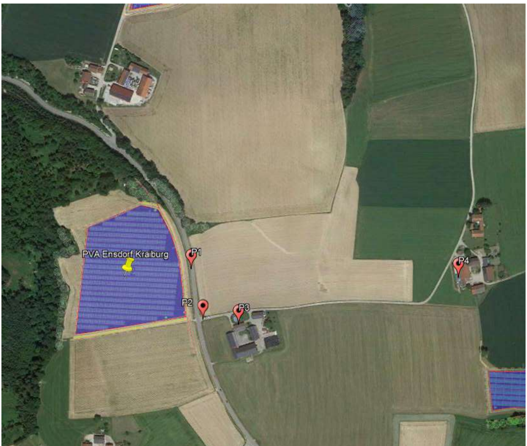
Bild 3.5.1: Übersicht über die PV Anlage und die gewählten Messpunkte (Quelle: Google Earth/SolPEG)
