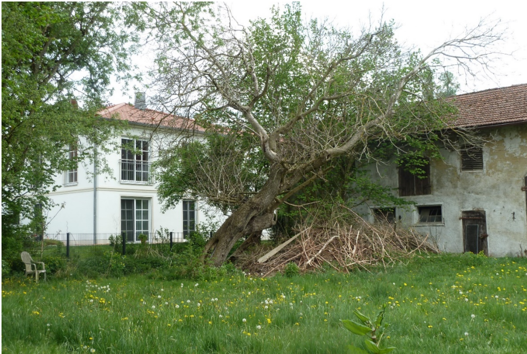
Abb. 7: Ansicht von Südwesten – Gartenfläche mit Nebengebäude (Foto: Jocham + Kellhuber, April 2020)
