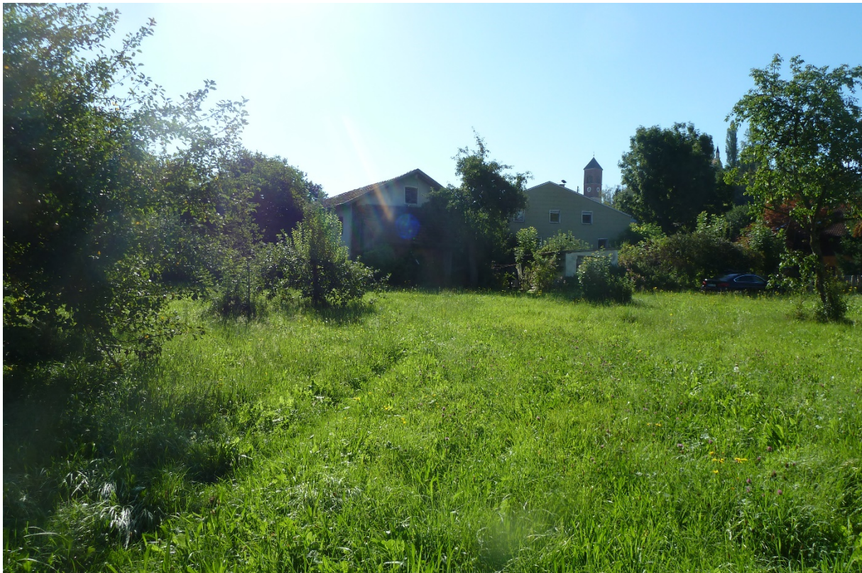
Abb. 20: Ansicht von Westen – Gartenfläche mit Nebengebäude (Foto: Jocham + Kellhuber, August 2020)
